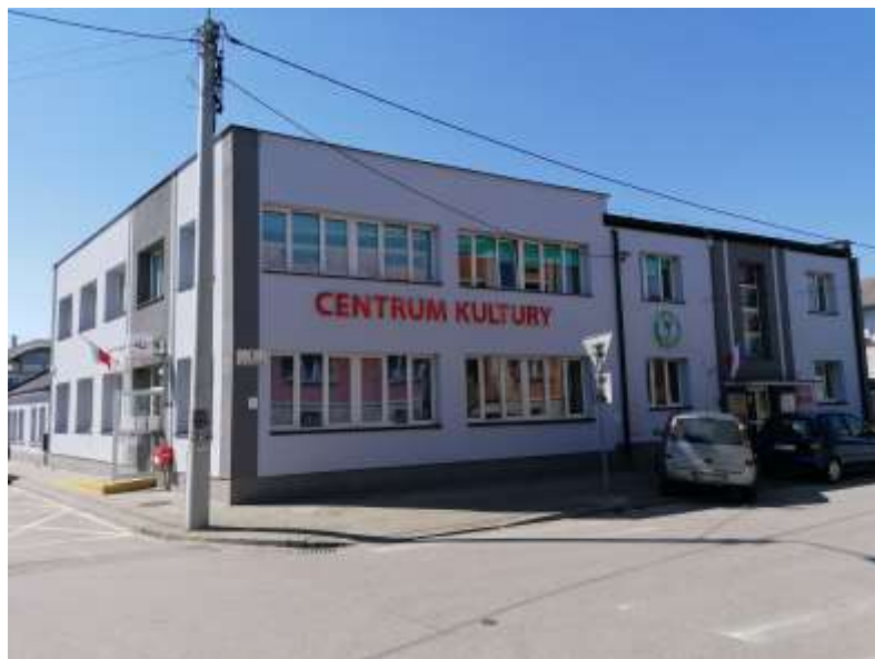
Termomodernizacja budynku GCKIKF w Jedlińsku
