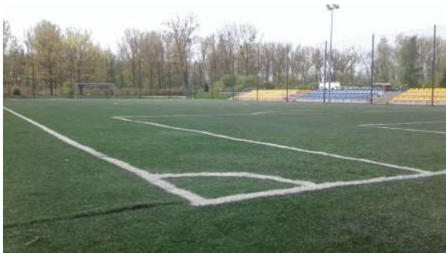
Remont boiska Orlik - inwestycja w trakcie realizacji
